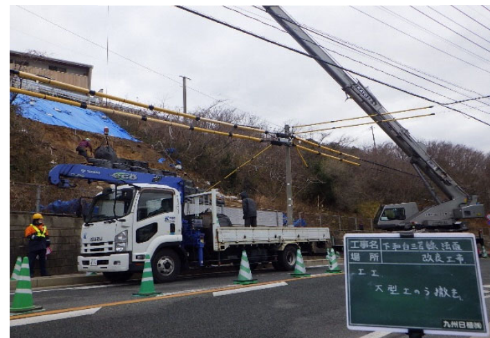
片側交互通行(大型土のう撤去工)
